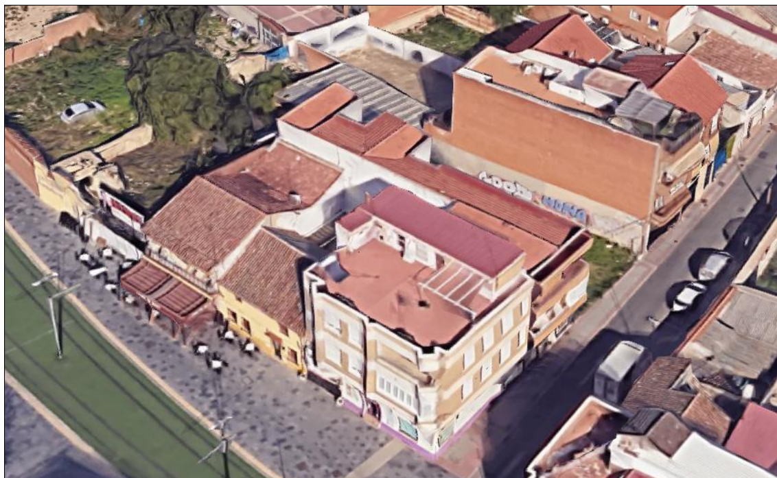
Edificaciones en la esquina de la calle Real con la calle San Roque.
