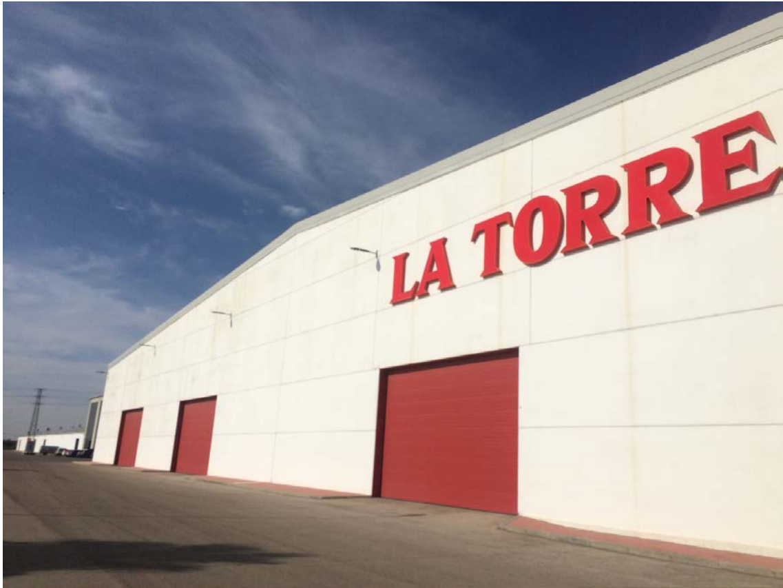
Detalle de una de las naves
