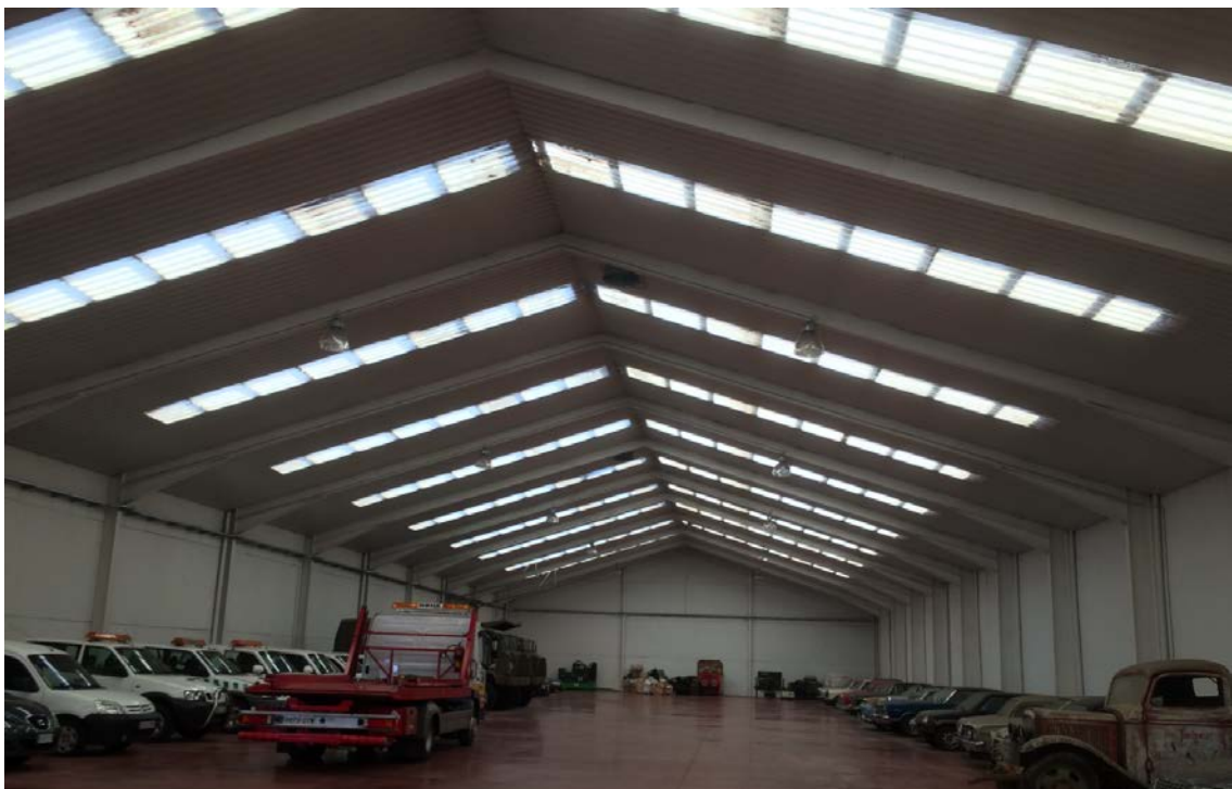
Vista de otra de las naves que se utiliza como taller de mantenimiento
