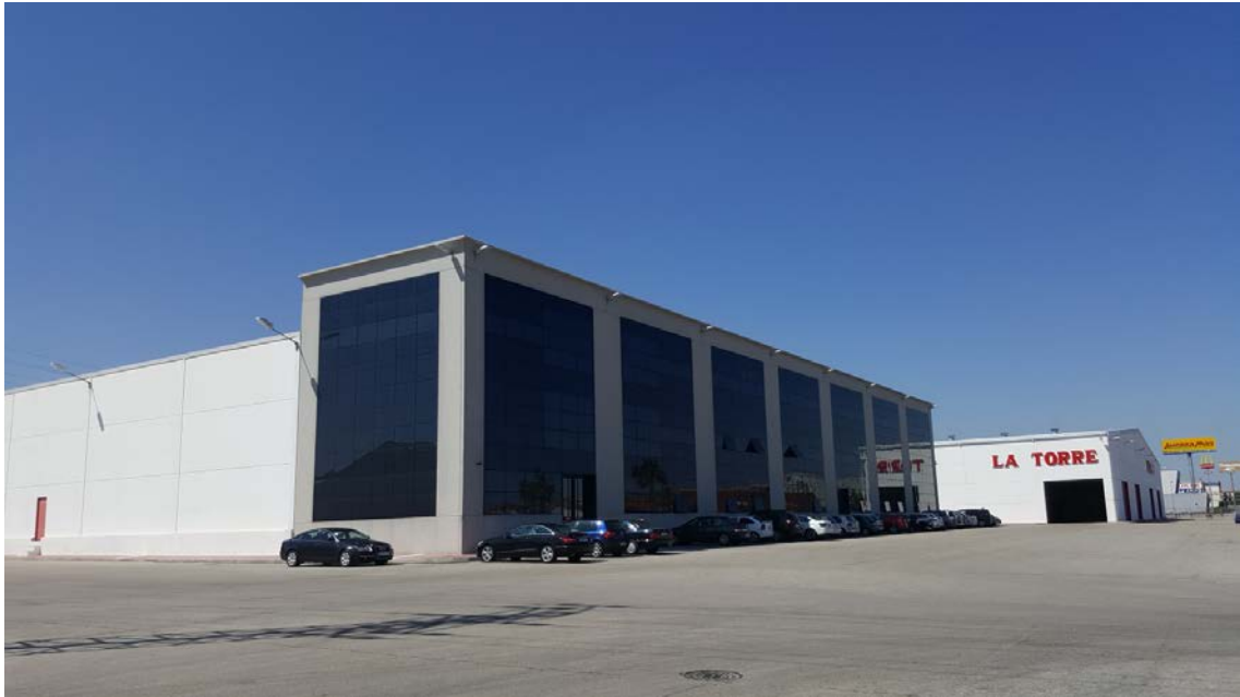
Aparcamiento exterior y edificaciones
